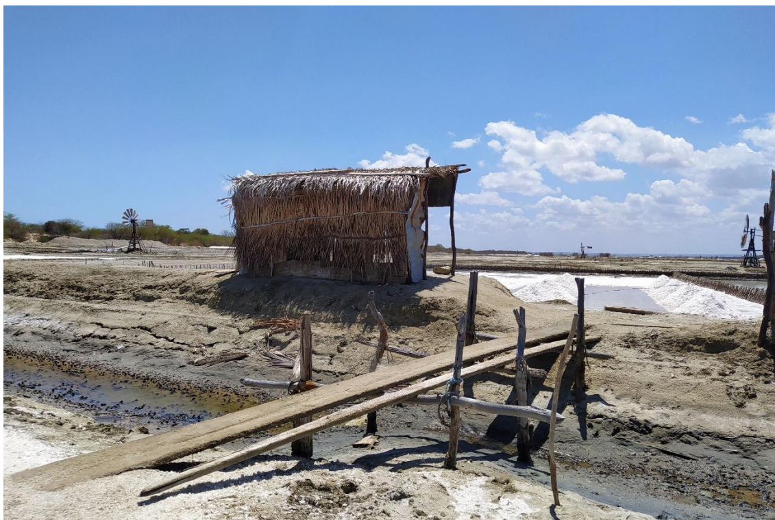
Figura 35. Abrigo (rancho) construído com madeira e palha, usados para proteger os salineiros do sol durante seu horário de descanso.
