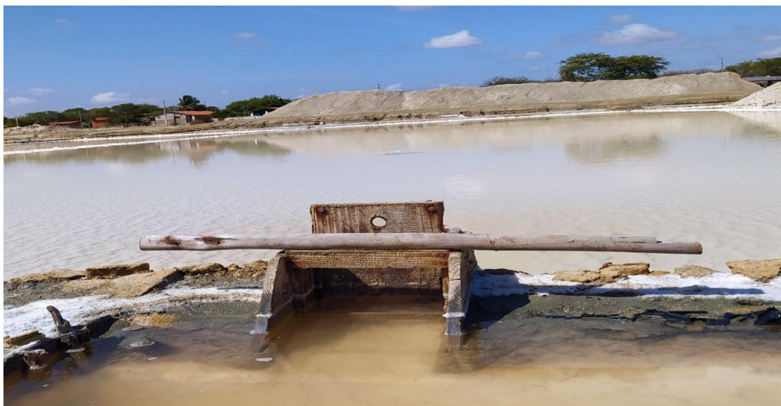
Figura 31. Comporta usada para controlar o abastecimento e drenagem das lagoas.
