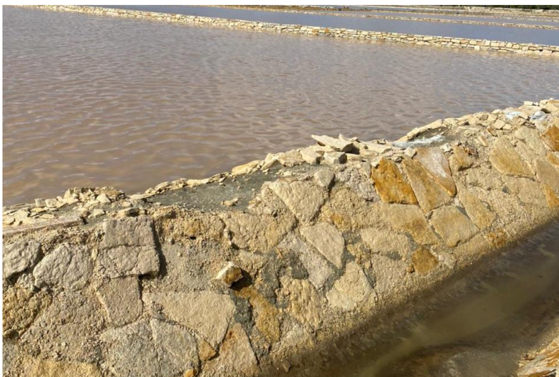
Figura 28. Proteção dos taludes feito com rocha de origem calcária.
