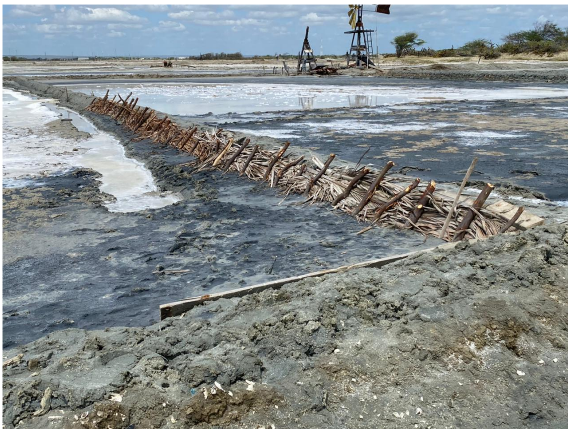
Figura 48. Interior dos tanques sujo de lama e material erodido das paredes.
