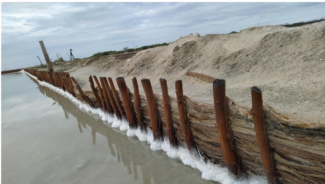
Figura 25. Proteção dos taludes feita com palhas de carnaúba fixadas com estacas de madeira.
