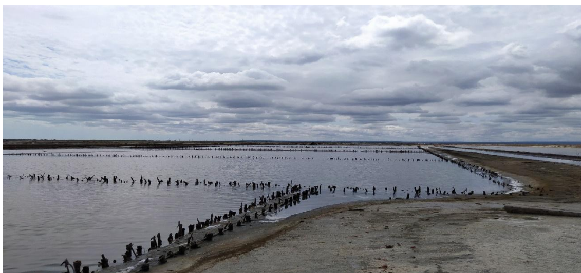
Figura 26. Diques sem a proteção da palha, erodidos após a estação chuvosa.
