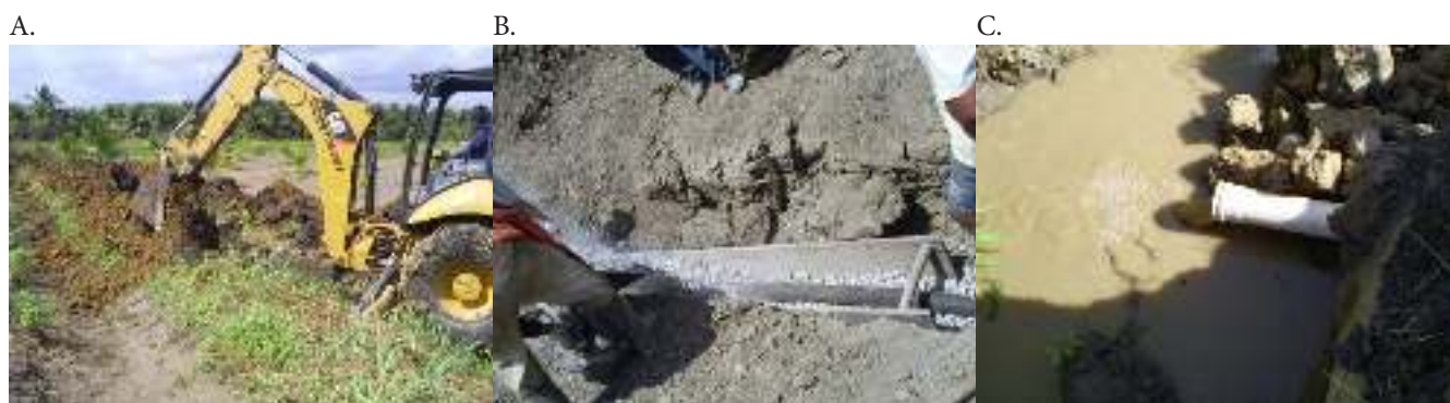
Figura 8. Instalação do sistema de drenagem subterrânea: abertura das valas (A), instalação dos drenos tubulares (B) e sistema em funcionamento (C) no Setor A do Perímetro Irrigado Curu Pentecoste
